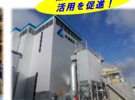
木質バイオマス発電施設の稼働(H31.2月竣工・発電開始)
